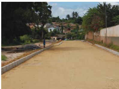
➤ Obra ligando Petrolar a Alagoínhas Velha.
